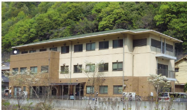
呉清明園外観(二河川側から撮影)。とても静かで、豊かな自然に囲まれており、二河川にはウナギや鮎が生息しています。
